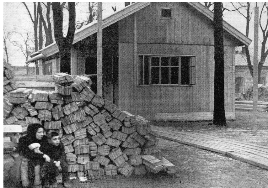
budowa domków fińskich na Jazdowie, 1945 r.
